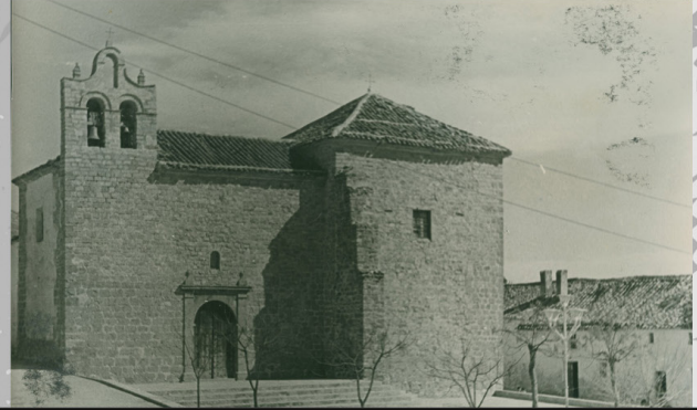
Vista panorámica de la Plaza Mayor y Iglesia Parroquial de San Francisco de Paula en Torrequebradilla Fuente: Fotos Gandía (Baeza)
